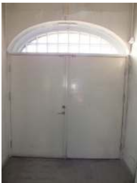
Foto på innerdörrarna till porten i bottenplan, den typ av pardörr som satt i entrén till källaren före bytet.
