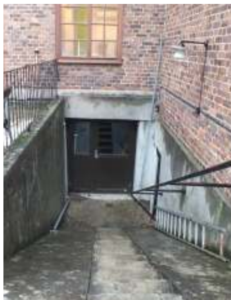
Foto på den nya källardörren i varmförzinkad stål med fönster.
