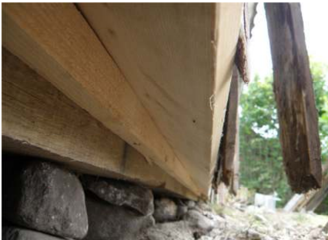
Fig. 5. Vattbrädans infästning mot fotträet.
