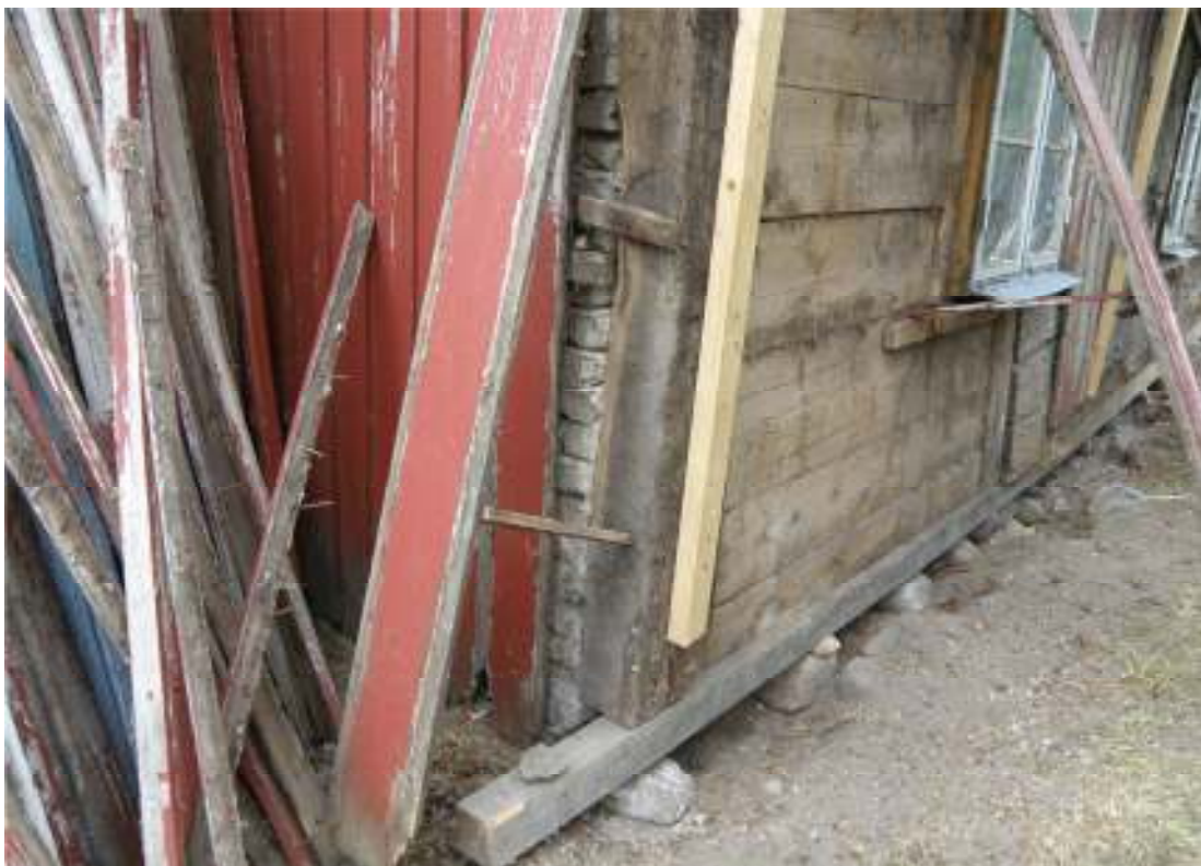
Fig. 3. Fotträets stötfog mot nordvästra hörnet (innan kapning av utskjutande del).
