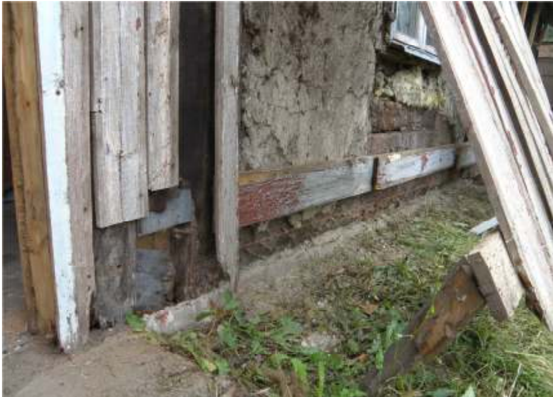
Fig. 2. Cementsockeln innan borttagning. Notera putsen på bålet samt träpliggarna.
