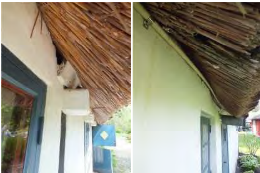
Framsidas synliga bindbjälkar med snedställd bräda. T.h. Baksidas vägg med påbyggd mur, där fönstren ej ligger i liv med fasaden, jämför med föregående bild.
