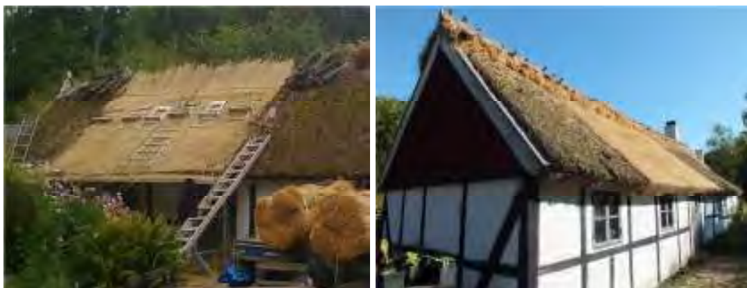
Kaffestugans framsida mot söder, under arbetets gång.
