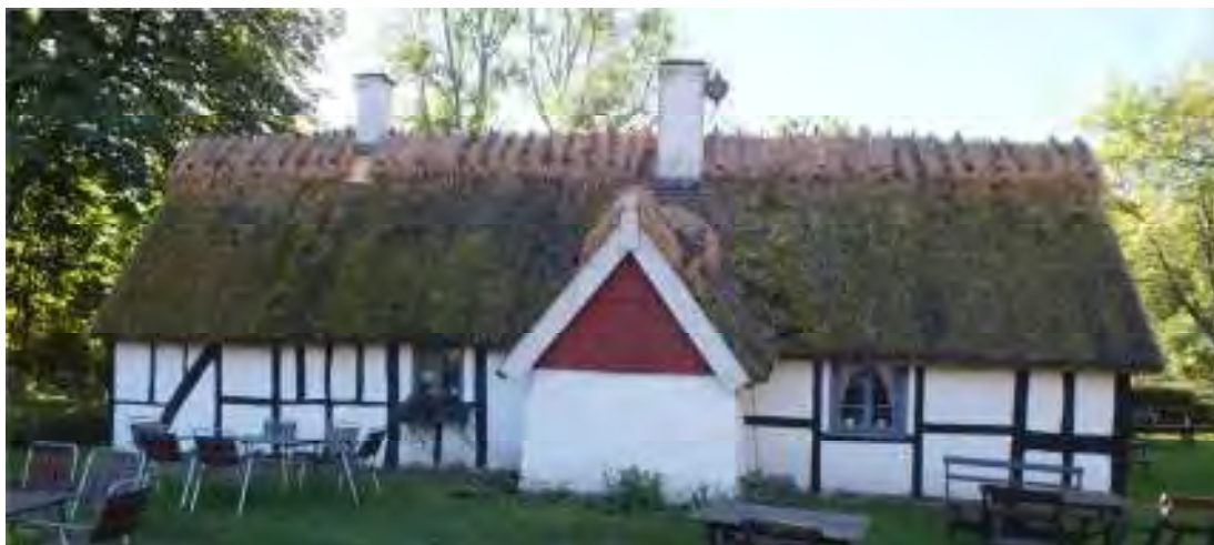
Den gamla smedjans norra sida med utbyggnad för bakugn, efter att ny ryggning gjorts.
