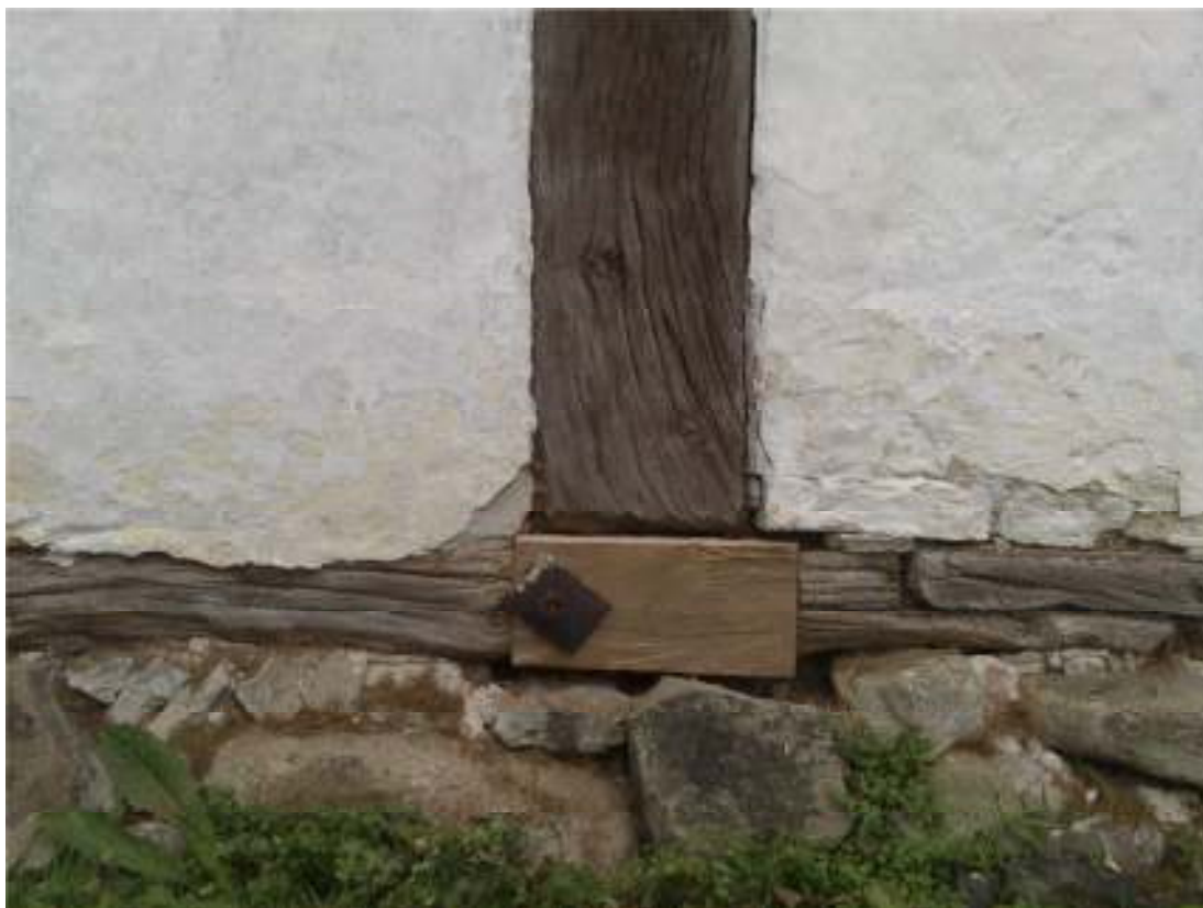
Västra längans västra fasad. Detalj av den sydliga fotträlagningen med det återanvända dragjärnet (högra rödmarkeringen på bilden ovan).
