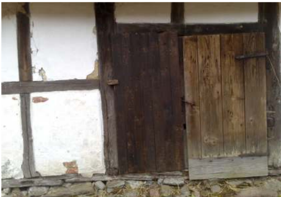
Östra längans bytta portblad (till vänster). Porten är fast monterat i stolparna och går inte att öppna.
